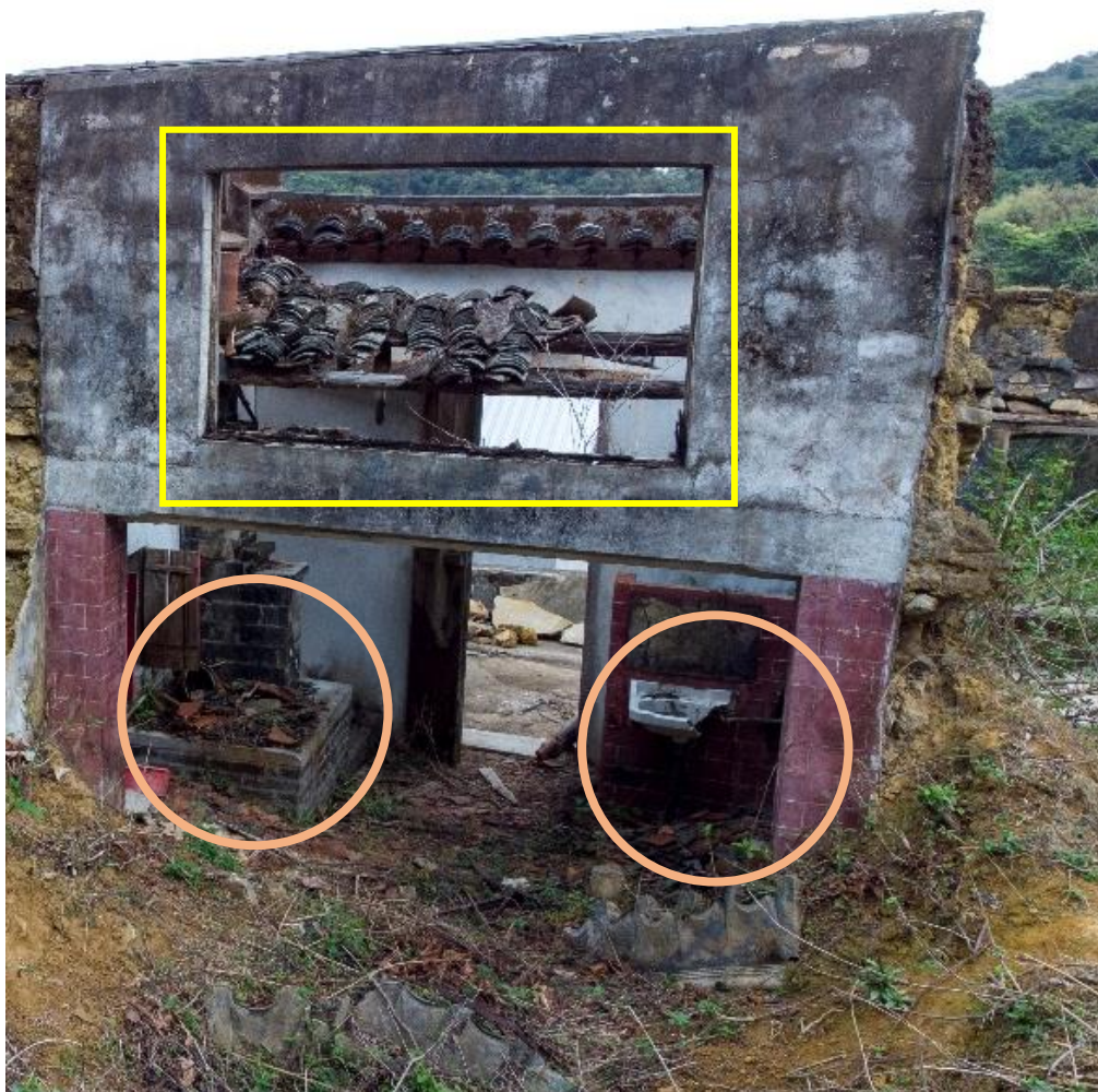
部分樓房仍留下廚房灶頭及洗手間設備（圓圈者），中空의牆板（方格者），特意設計有通風的作用。
