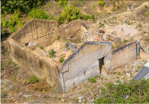
老屋的夯土牆
