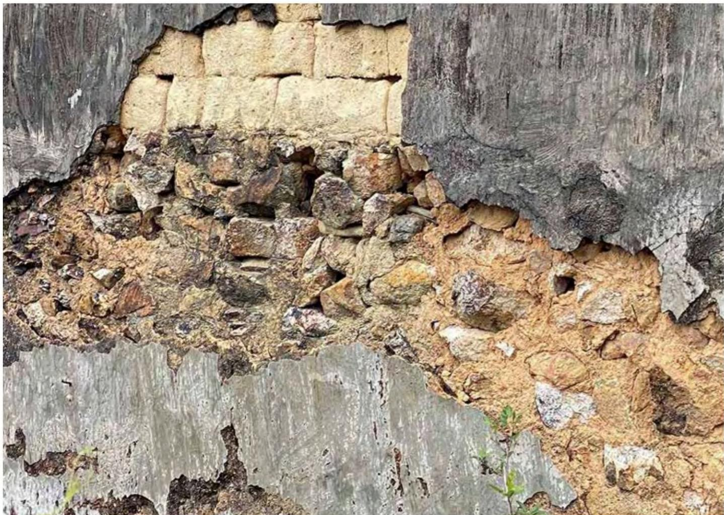
老圍各屋宅的材料細節：土磚、夯土、礫石與批盪的結合。
