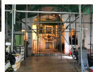
小堂內部復修中
