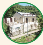
北潭涌聖母七苦小堂 三級歷史建築
