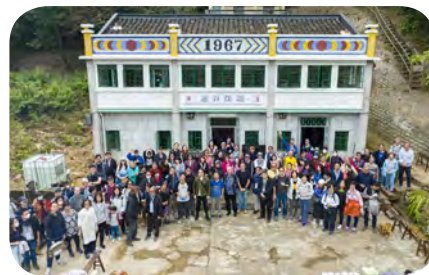
修復後的五肚楊屋
