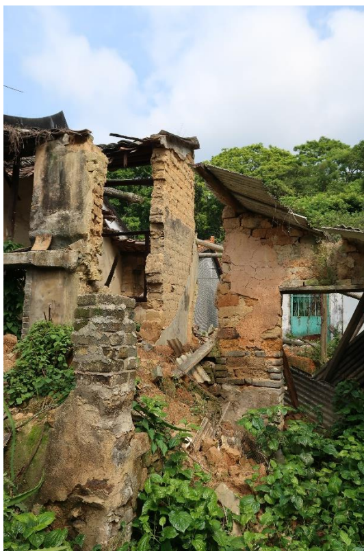
圖十五：從破爛的村屋見到早期的建築材料以黃泥為主
