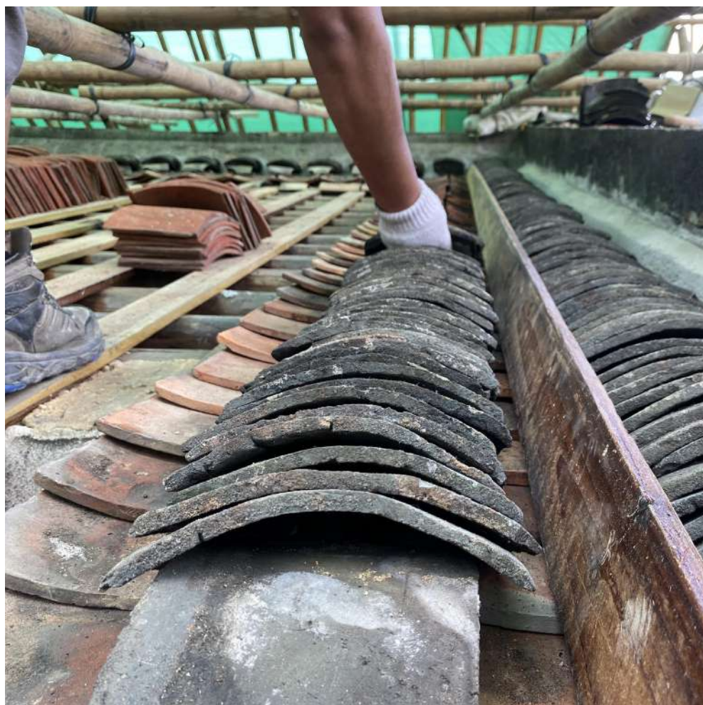
重鋪瓦片(板瓦和小清瓦) Roofing (flat tiles & blue tiles)
