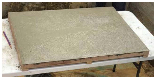
15. 用灰匙將石米壓實、壓進砂漿裡。
