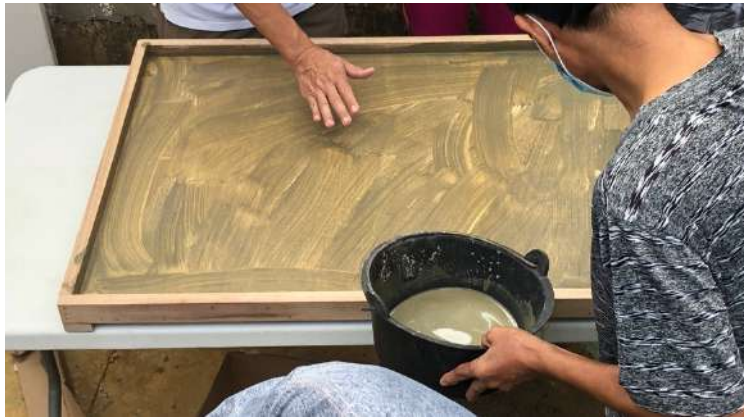
1. 先在木盤裡塗抹一層薄英泥漿。
