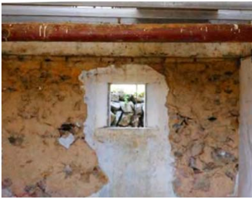
Earth Mortar 泥漿砌石
