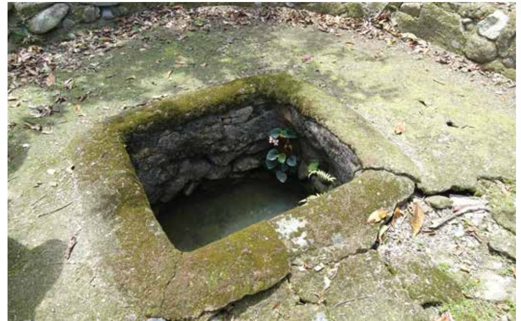
深涌村落的用水全靠河溪供應。可是灣仔的屋舍離主要河溪較遠，故設有一口古井，昔日供村民打水使用。
