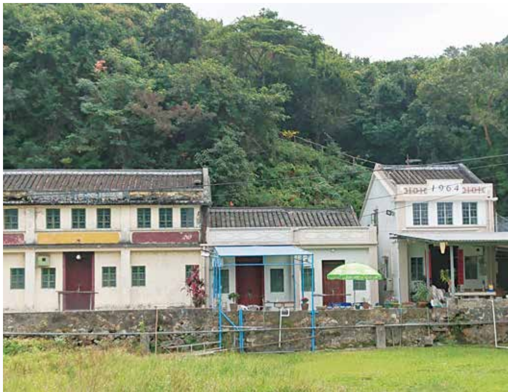
灣仔的村屋位處高台上，背有靠山；設計簡單實用，地下的窗戶通常較二樓的少，以作防禦。部分屋舍正面頂部刻着建屋的年份。
