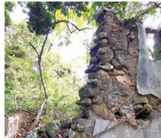
深涌村民就地取材，以石材、黏土建屋。
