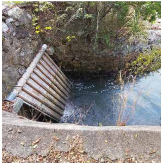
這天海堤後方水位較高，河水推開水閘流出大海。
