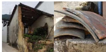
牆拆除至1.5米高 (屋內計) 鑲嵌瓦片作特式牆身
