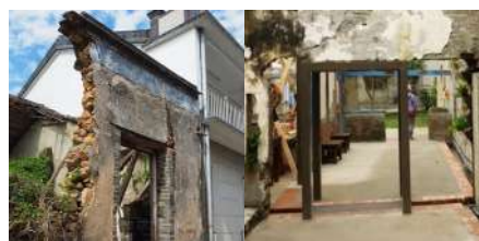
以鐵架加固牆身 (參考台西老街改造)
