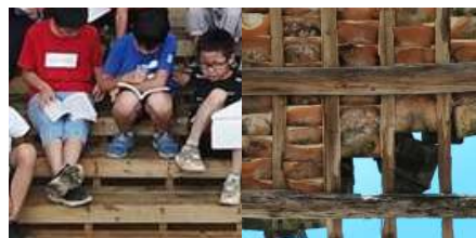
梯級式小聚木地台 重用拆除的屋頂木樑 (經防蟲處理)
