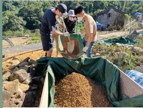
中大團隊就地取材，沿用梅子林當地的泥土建造夯土牆，並以科學方法測試村內不同泥土及改善夯土配方。
