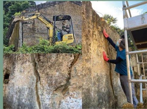
為了鞏固原有外牆的結構，中大團隊修復老屋時，填補牆上的裂縫，並將傾斜的外牆重新扶正和加固。
