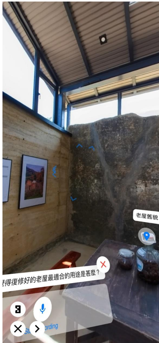
為了鞏固原有外牆的結構，中大團隊修復老屋時，填補牆上的裂縫，並將傾斜的外牆重新扶正和加固。
