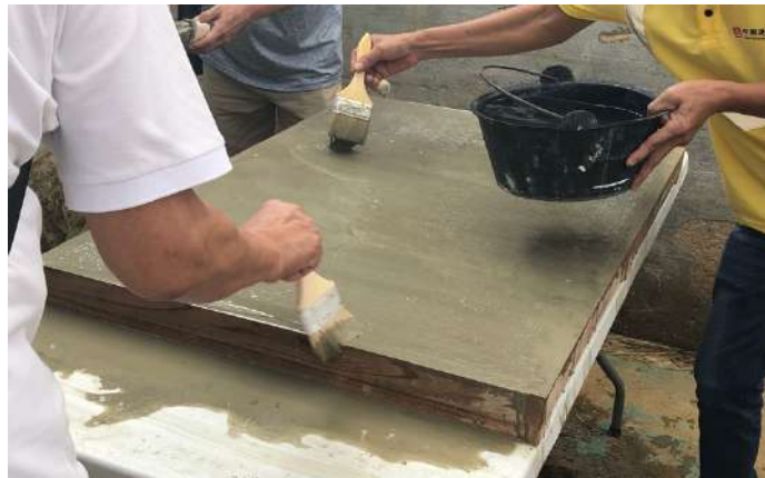
17. 石米漿乾至不會黏稠，便可用水和掃輕輕洗掉多餘的石米漿，露出石米。
