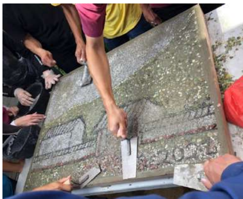
15. 用灰匙將石米壓實、壓進砂漿裡。
