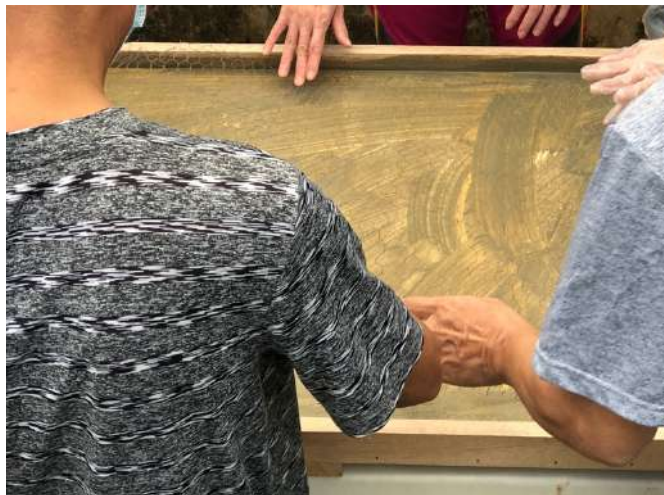
2. 量度批盪網所需的尺寸，用剪刀剪出合適尺寸的批盪網。
